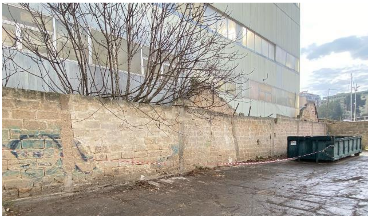
Figura 17 - Dettaglio ribaltamento muro di cinta
