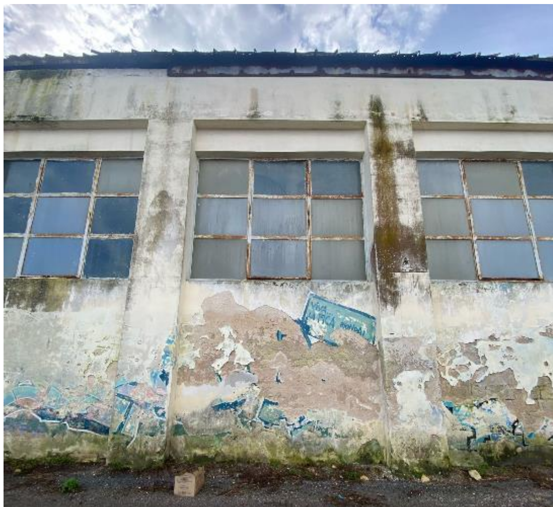
Figura 6 - Capannone Ex Saca Nord deterioramento facciata
